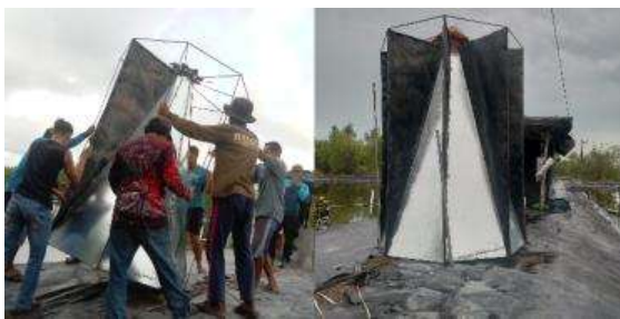
Gambar 7. Pembangunan kerangka turbin angin
