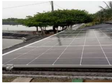
Gambar 8. Pemasangan panel surya di dekat tambak
