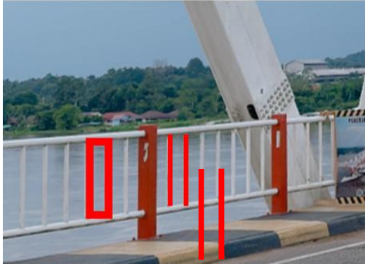
Gambar 4. Pagar Jembatan Tayan
