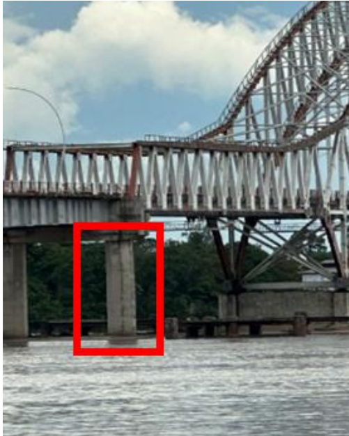
Gambar 6. Tiang Jembatan Tayan
