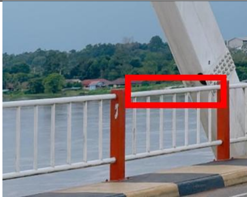
Gambar 7. Pagar Jembatan Tayan
